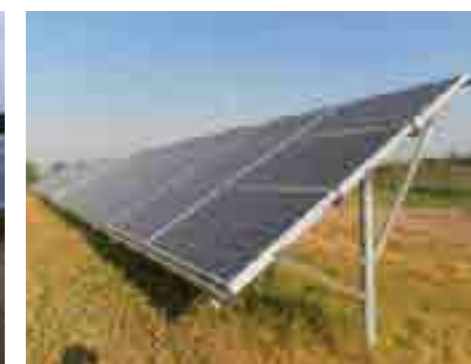
Monopalo con 3 moduli con cornice orizzontali
