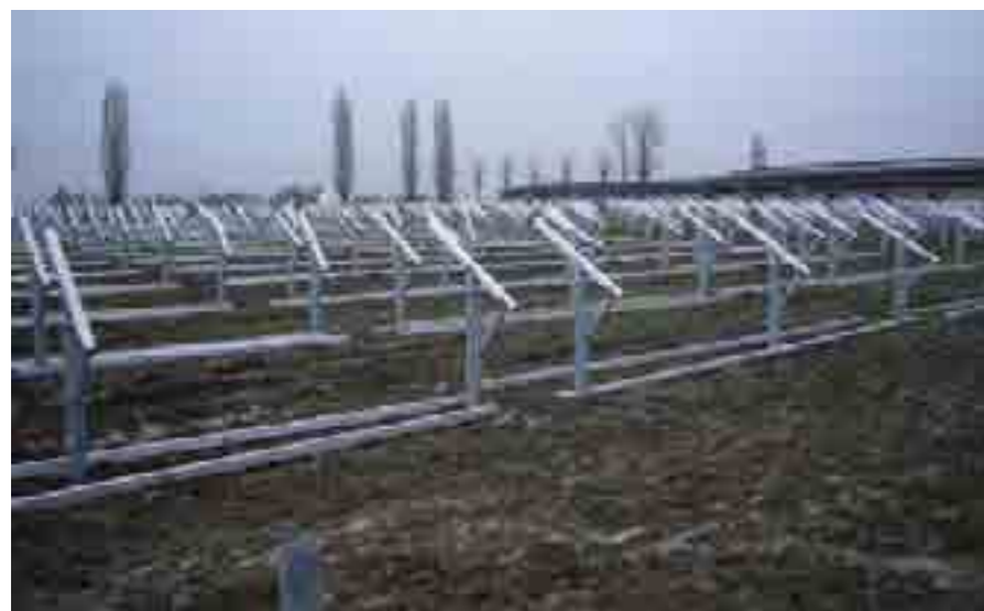
TATV4: monopalo con un modulo con cornice verticale
