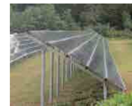
TATF1: doppio palo 5 moduli in vetro orizzontali. Soluzione di fissaggio moduli certificata dal produttore First Solar
