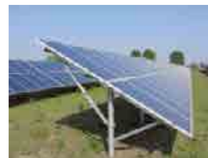
TATF1: monopalo con 2 moduli con cornice verticali
