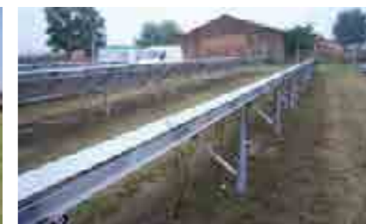
Monopalo con 1 modulo con cornice verticale
