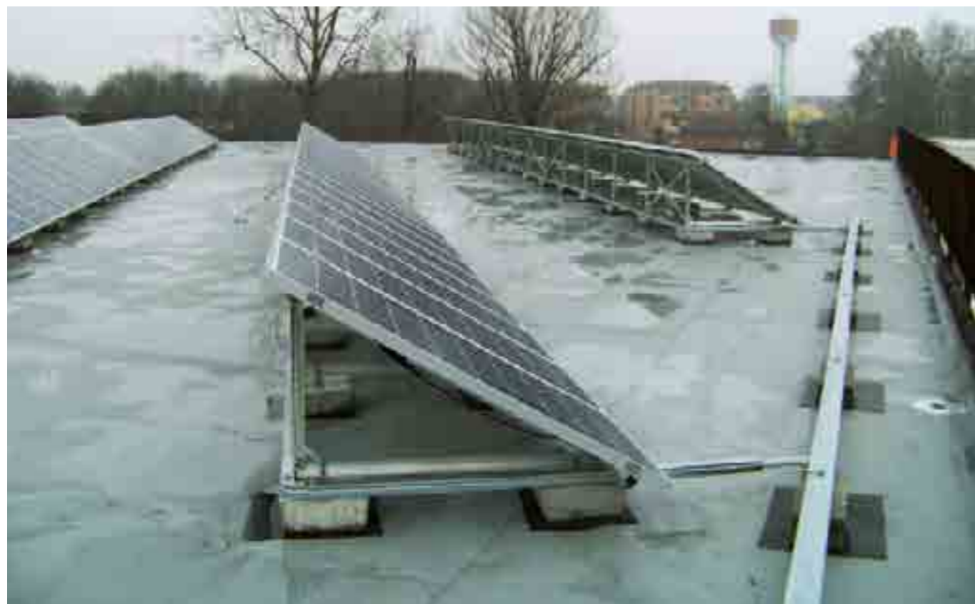
Esempio di applicazione su tetto piano
