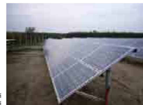
Monopalo con 2 moduli con cornice orizzontali
